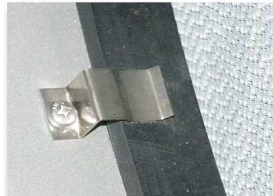
Gummidichtung, alternativ zur Filzdichtung
