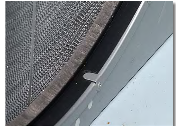
Bürstendichtung für Standard Raumluftechnik
