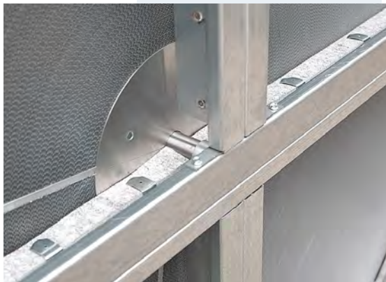
Druckstabile Filzdichtung für Standard Raumluftechnik
